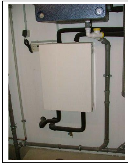
Pumpen-Gruppe im Gehäuse Deckel komplett abnehmbar
